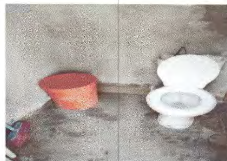
Foto 8: Sustitución de inodoro
