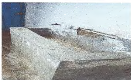
Foto 11: sustitución de llaves de chorro
