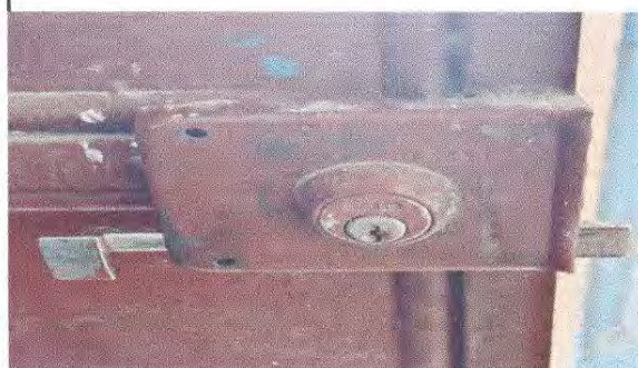
Foto 3: Sustitución de chapas
