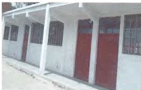
Foto 7: Sustitucion de pintura de escuela
