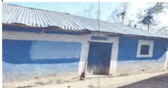
Foto 2: Sustitución de lamina troquelada para cocina
