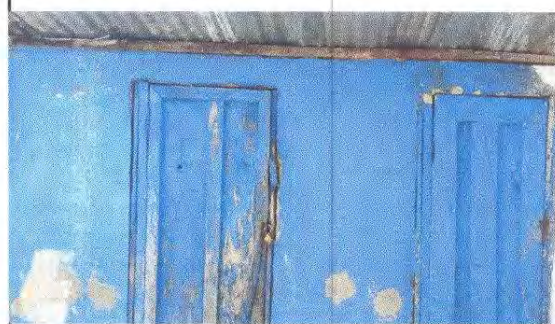
Foto 4: Sustitución de puertas de metal
