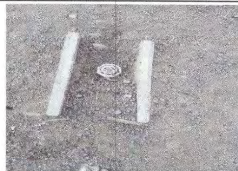
Foto 10: Sustitución de caja de registro y llave de globo
