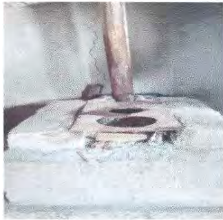
Foto 13: Sustitucion de estufa rural (completa chimenea plancha de metal)
